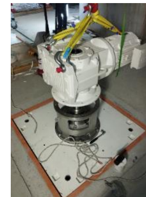
Mise en place motorisation agitateur
